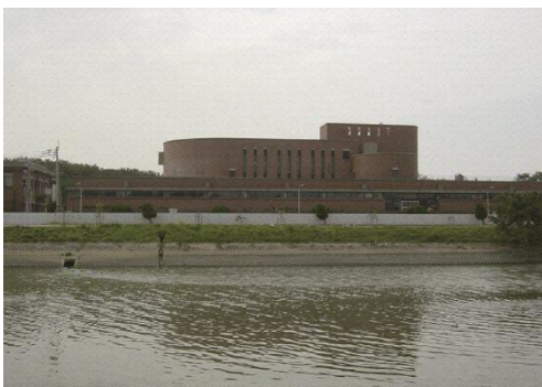
古賀水再生センター
